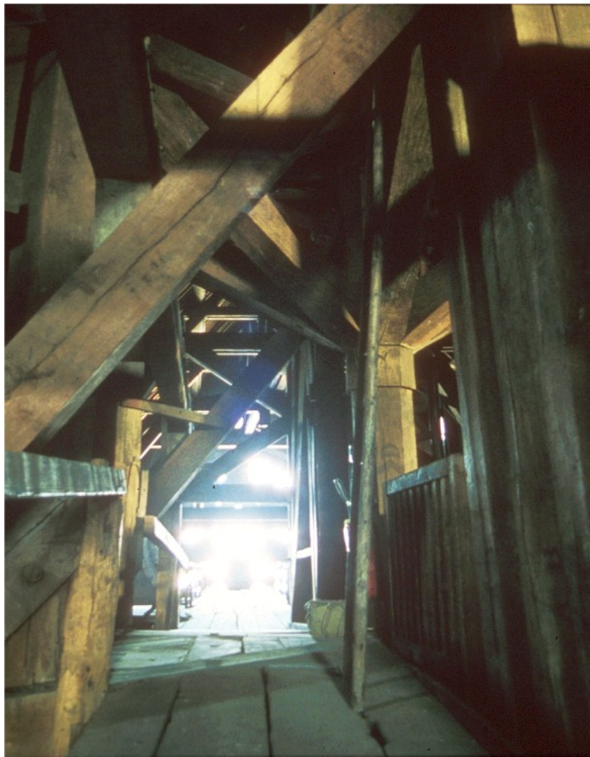
Pose photographique du poinçon central. L'endroit est très sombre.
