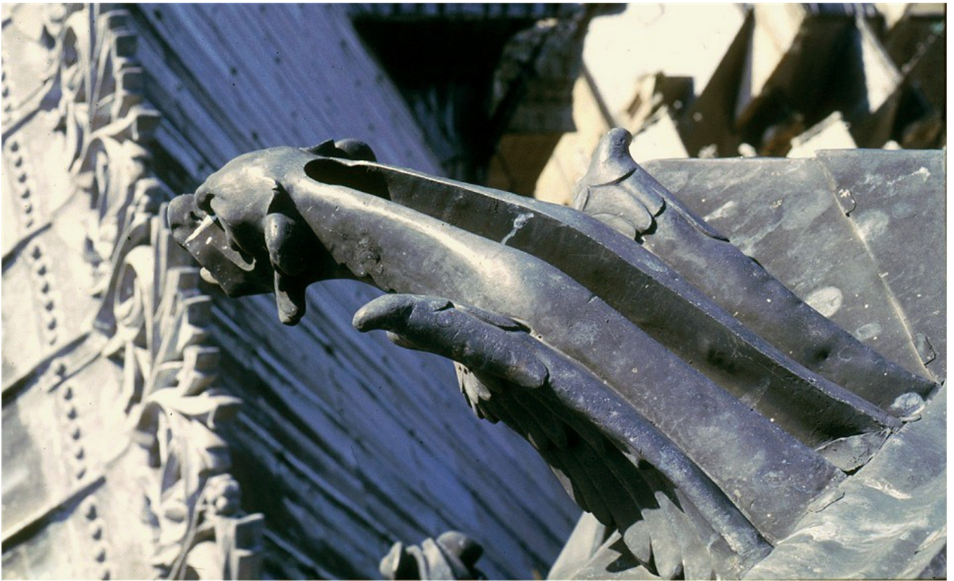
Gargouille évacuant l'eau de pluie au premier terassin de la flèche de la cathédrale Notre-Dame de Paris
