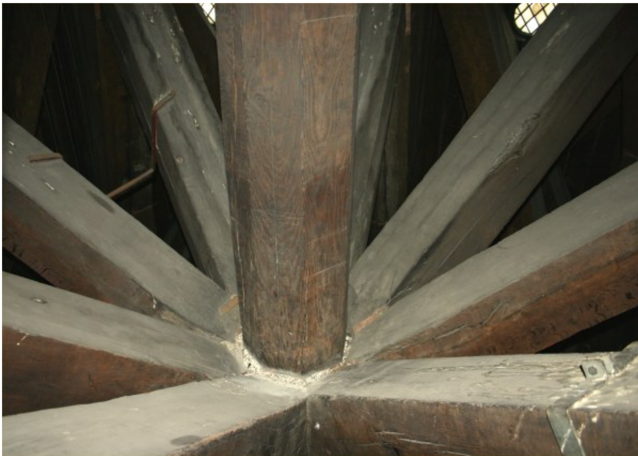
En cours de montée, dans l'escalier, coup d'oeil au jeu de poutres partants du pignon central.
