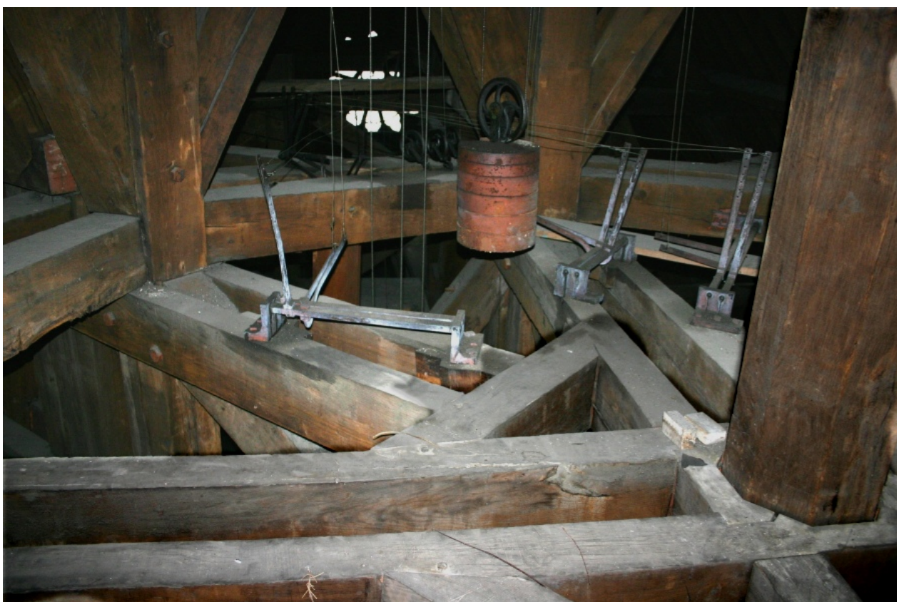
Une enrayure, au cours de l'asension. Le poids qui pend servait à animer l'horloge mise sous Viollet le Duc, en 1867, par l'entreprise d'horlogerie Collin, rue Montmartre, à Paris. Cette enrayure révèle la forme octogonale de la flèche.
